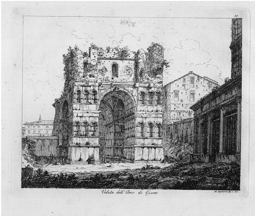
L'edificio ha pianta quadrata (12 m di lato per 16 m di altezza), con quattro massicci pilastri che sostengono una volta a crociera, per la cui costruzione sono stati impiegati marmi ed elementi cementizi di recupero. E' detto di Giano che non e' il Dio bifronte, ma deriva dal latino Janus o porta /passaggio coperto per il riparo dalle piogge .
